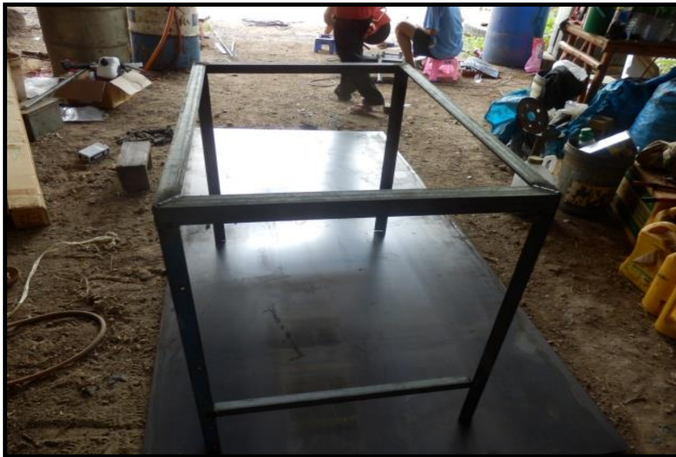
ภาพที่ 4-3 ขึ้นโครงสร้าง
